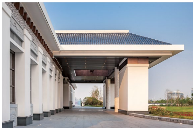
专机楼陆侧雨篷近景照片
