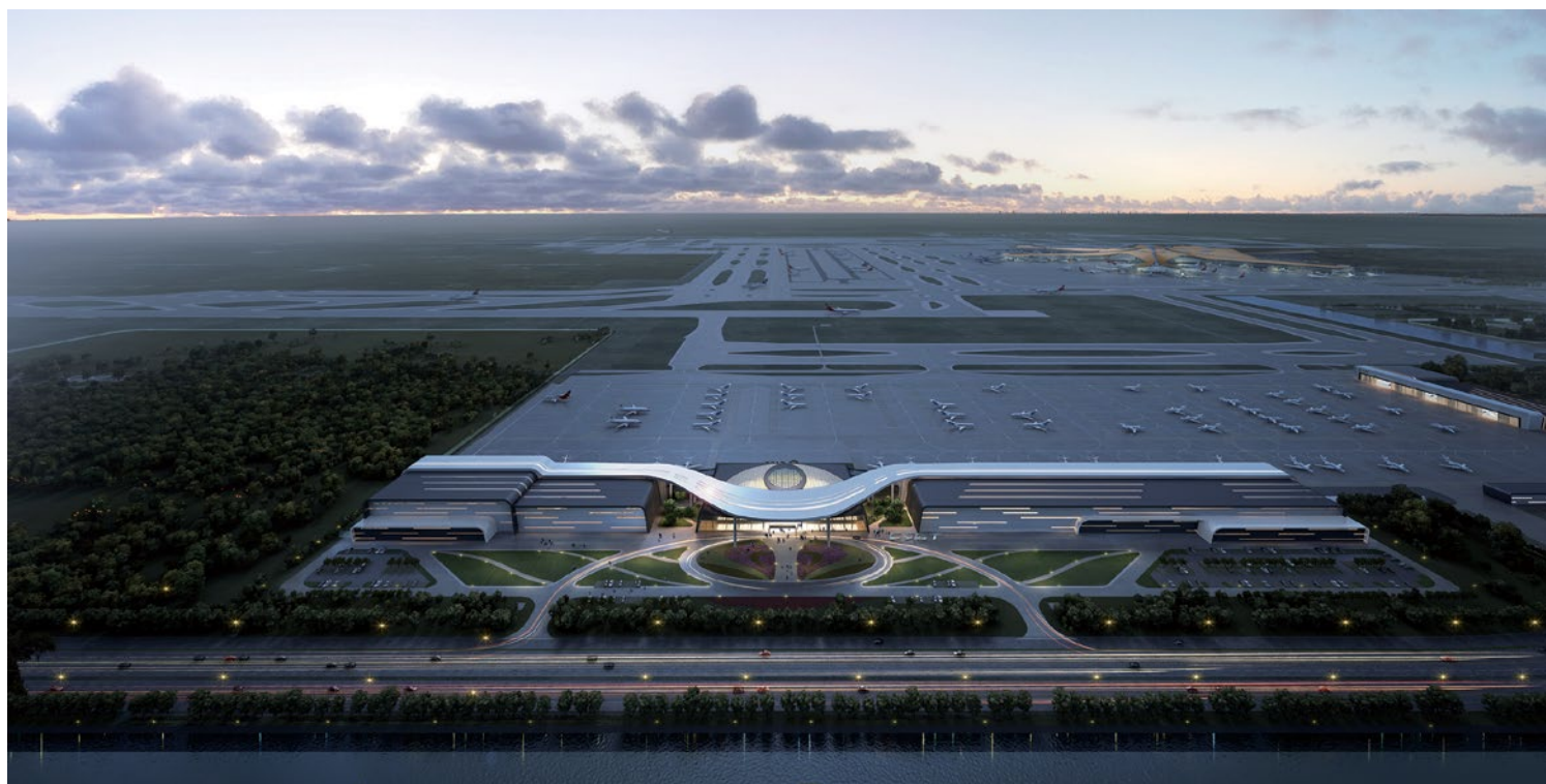
项目名称：新机场公务机工程项目 建筑面积：92万m 2 设计时间：2016年12月
