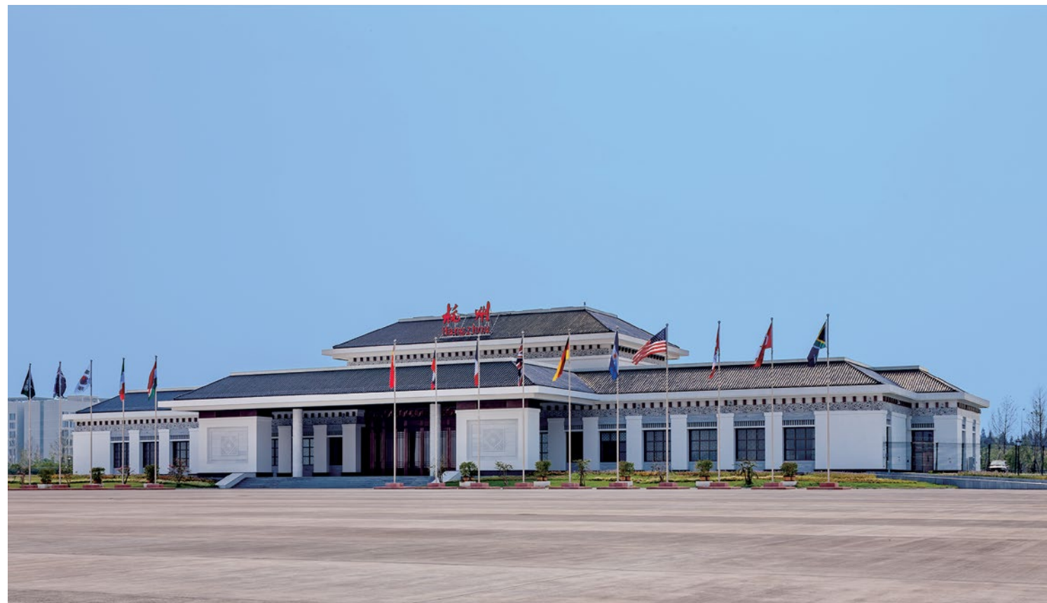
专机楼空侧全景照片
