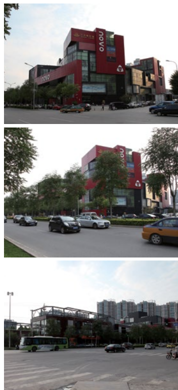
现场现状照片
