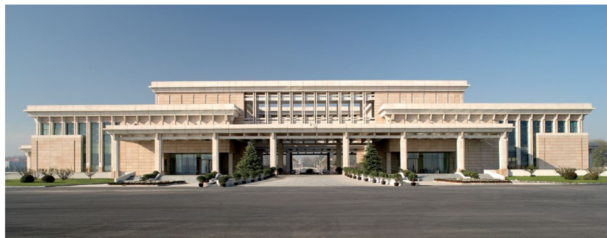
专机楼空侧全景照片
