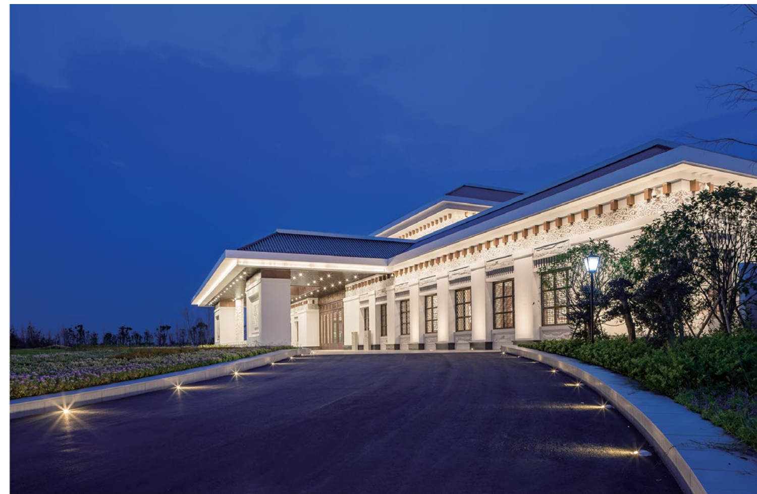
专机楼陆侧近景照片
