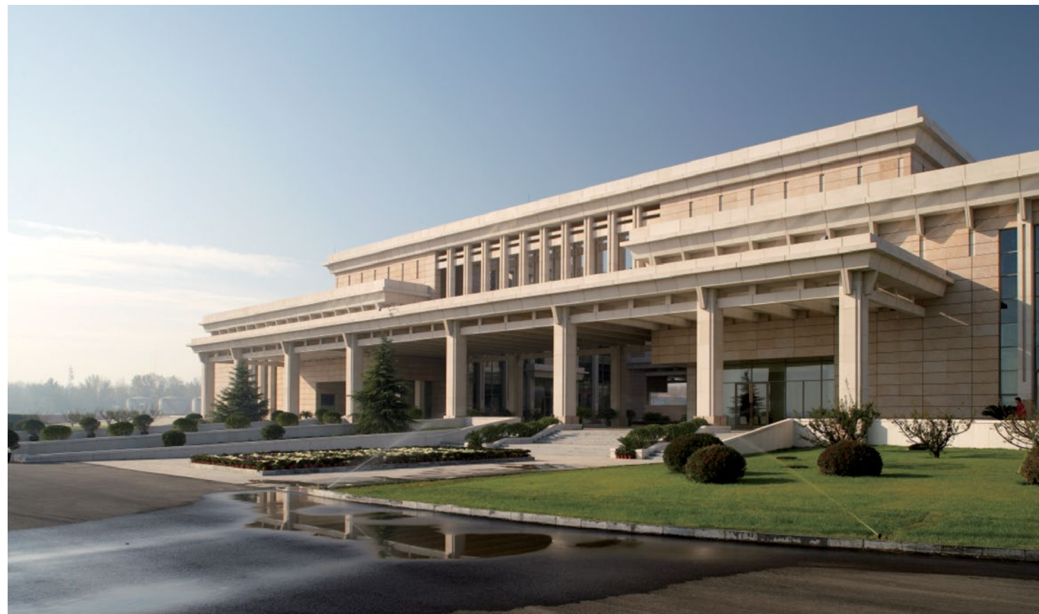
专机楼空侧近景照片
