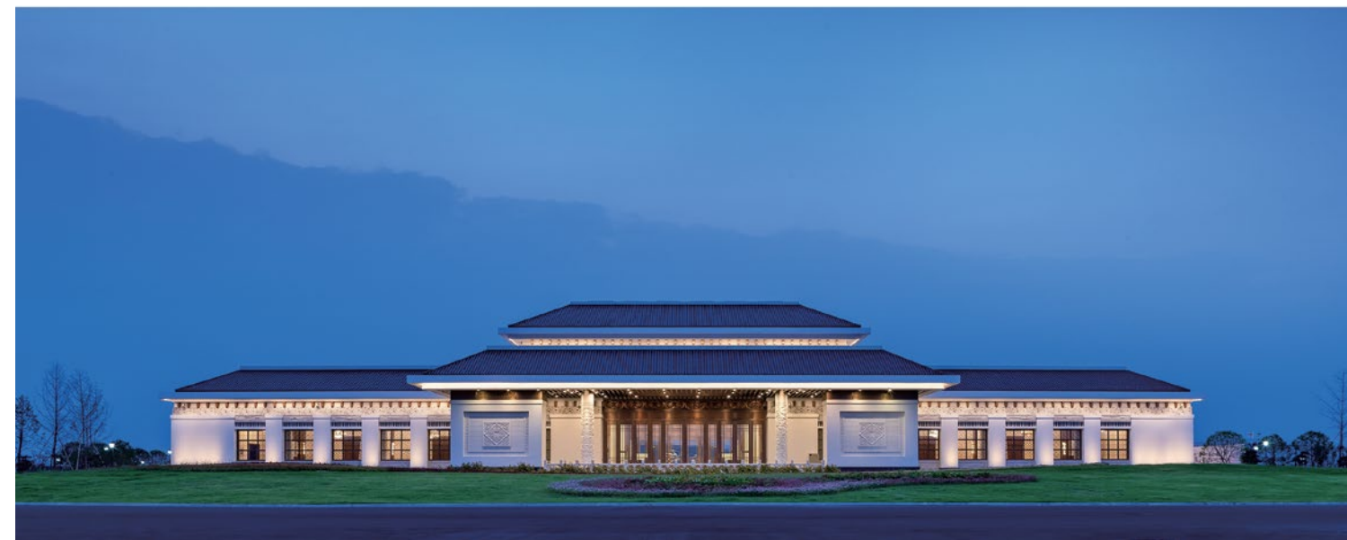
专机楼陆侧全景照片
