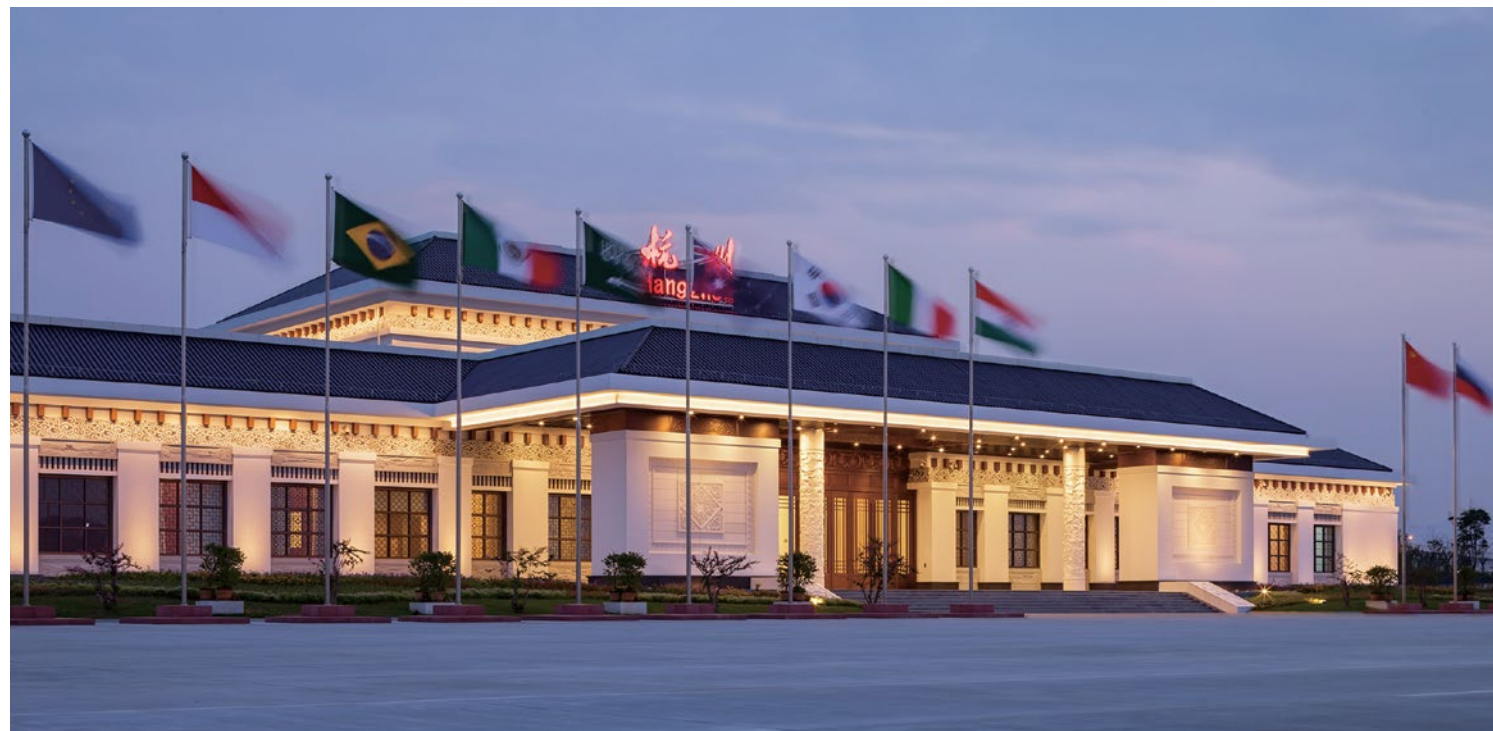
专机楼空侧近景照片
