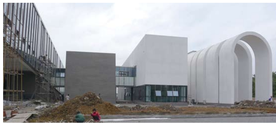
施工现场照片
